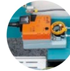
Zuluftklappe mit Stellmotor
